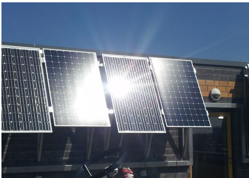
Abbildung 6: Veranschaulichung der Reflexion an einem texturierten Modulglas (mitte-links) und einem glatten Modulglas (mitte-rechts) – Quelle: Fraunhofer-Institut für Solare Energiesysteme ISE
